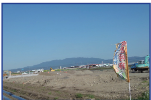
【都城 IC 付近の進捗状況】
